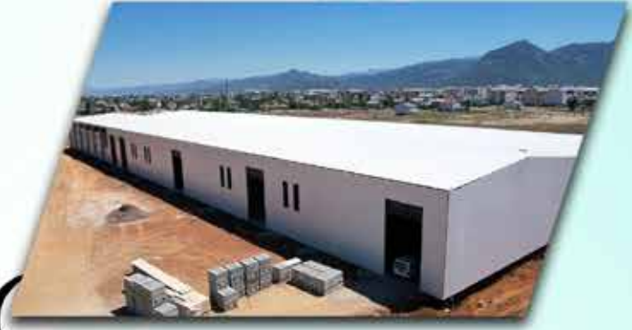
Soğuk Hava Deposu
