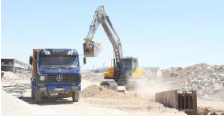
Alparslan Mahallesi'nde 400 milimetre çapında betonarme boru ile yeni kanalizasyon şebeke hattı yapımı ise sürüyor. Buranın
