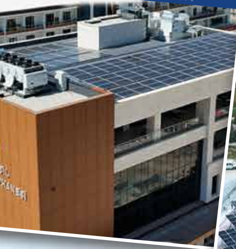
Yeni Nesil Şehir Kütüphanesi GES Panelleri
